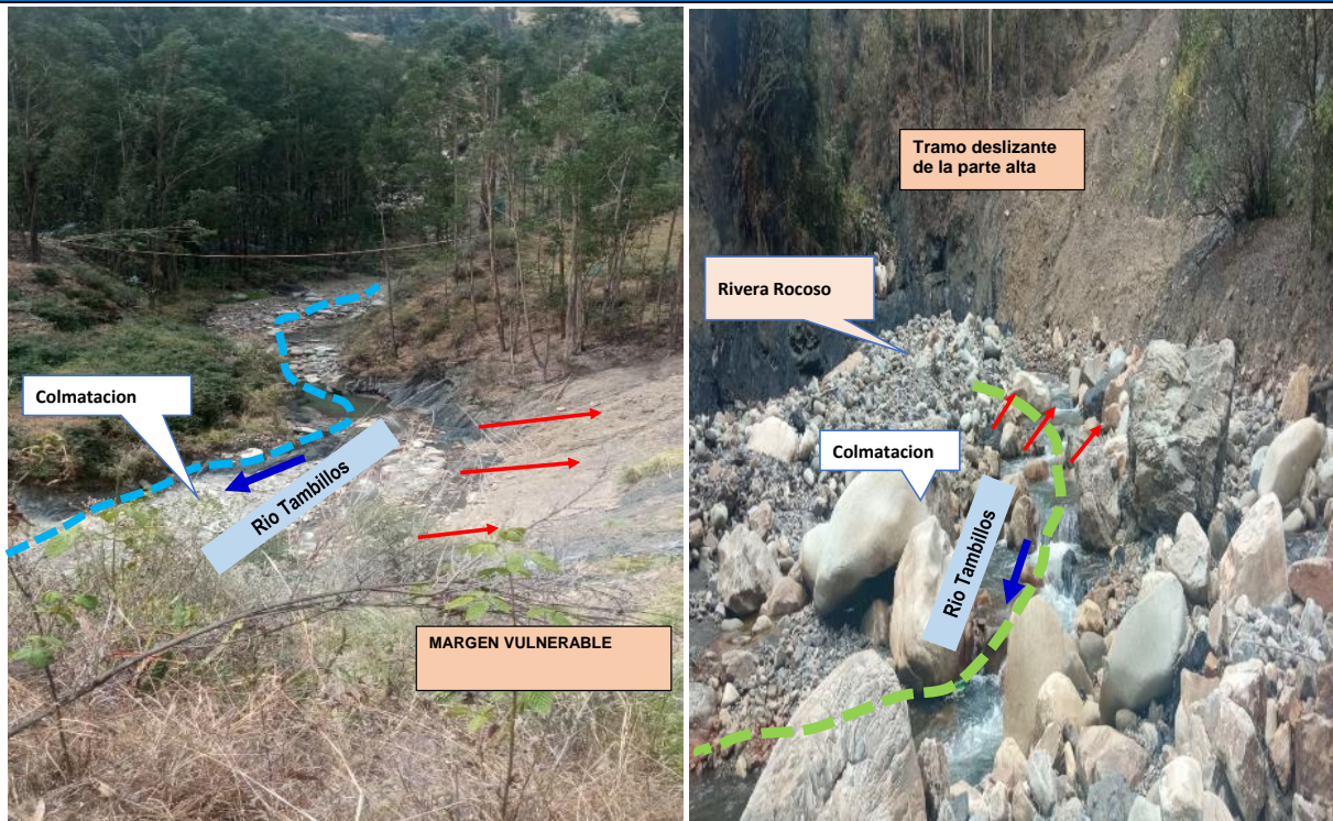
FIGURA N°01: TRAMO DESLIZANTE DE LA PARTE ALTA EN LA MARGEN IZQUIERDA, COLMATACION DEL CAUCE
